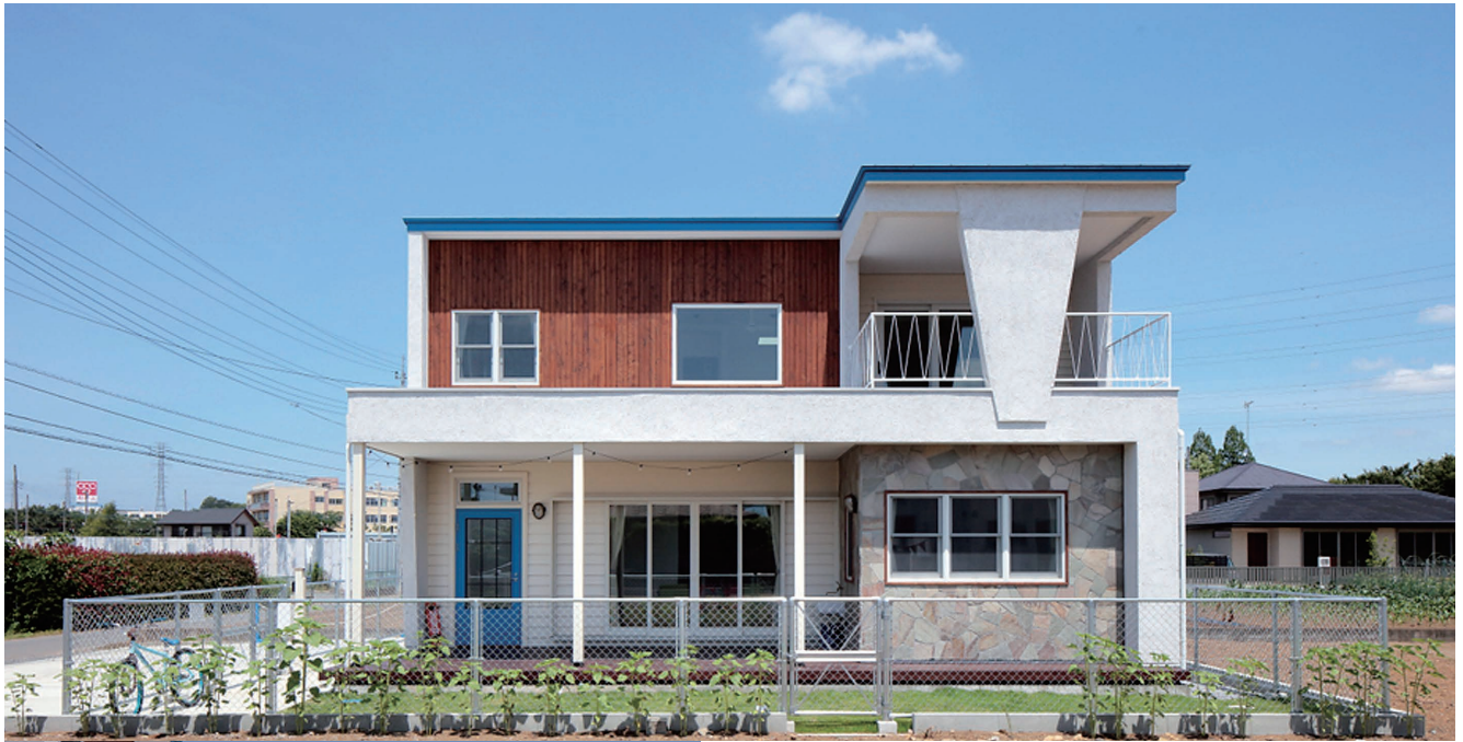
アメリカ西海岸の風を感じる佇まい。外装にはシラスそとん壁（100%自然素材）・木製断熱玄関ドア・アンダーセン木製窓・板張り・乱形石張り・スチール手摺などを用いた
