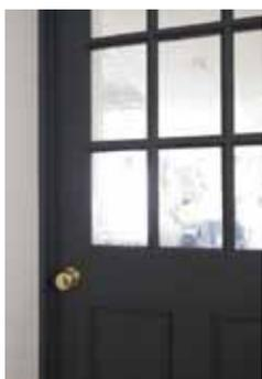
無垢のベイツガ材（ヘムロック）を使った標準仕様の室内ドア。水に氷が張ったように見えるガラスは、アンティーク風の輸入製品
