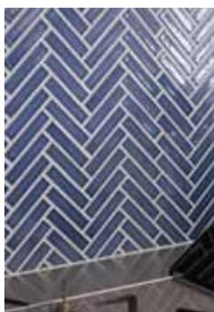
ヘリンボーン張りで仕上げた艶のあるタイルは、聖和セラミックス製。キッチンなので、目地は油が染み込まないタイプを使用
